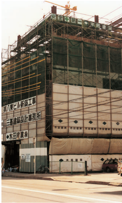
建築中の第8東ビル
