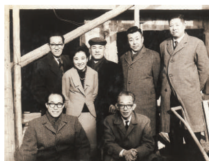
小石川マンション 上棟式
