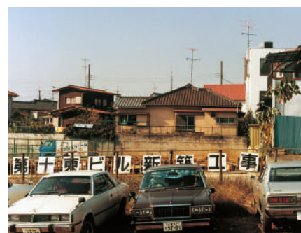
第10東ビル新築現場
