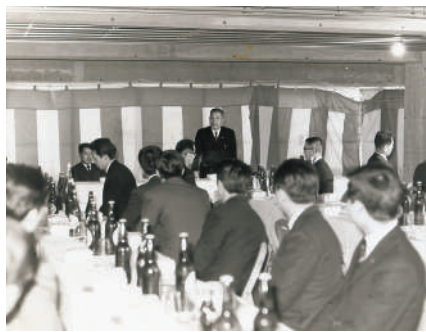
第5東ビル上棟式
