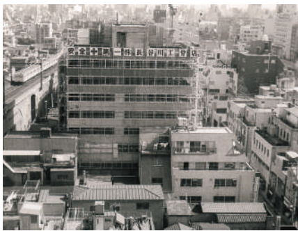
建設中の第5東ビル
