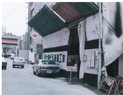
第6東ビル建築現場
